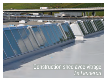
Forme classique d'un toit shed
