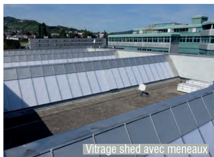
Vitrage shed avec meneaux
