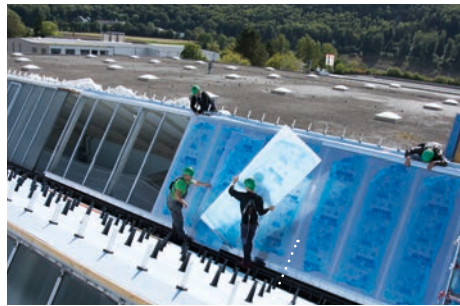
Vitrages shed, 600 mètres de plaques alvéolaires, Bosch, Beringen/ZH
