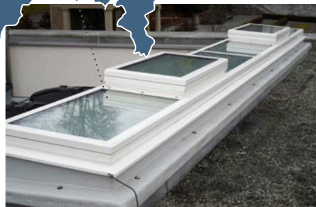
Lanterneaux vitrés avec commandes EFC, Crématorium Lucerne
