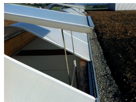
Lichtband mit Tandem-Zahnstangenantrieb
