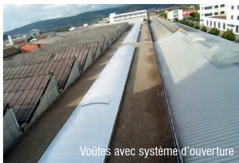
Voûtes translucides courbes avec fonctions d'ouverture, Aéroport Zürich
