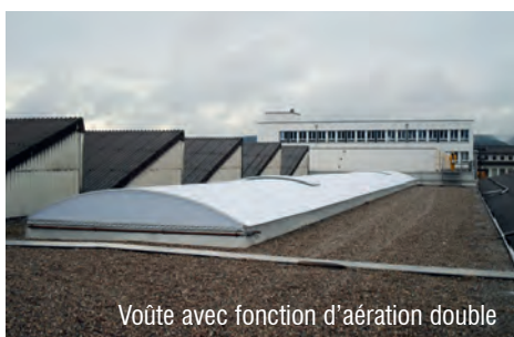
Voûte avec volet d'aération
