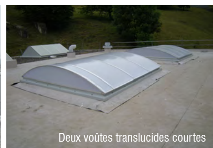
Voûte avec fonction d'aération double
