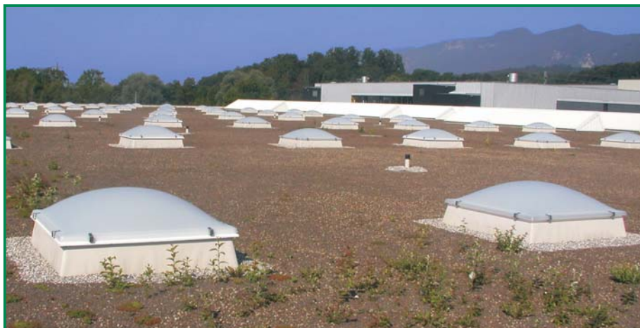
Lichtkuppel und senkrechter Aufsatzkranz mit elektrischem Kettenantrieb als Öffnungsvorrichtung. Coupole translucide et costière verticale avec moteur à chaîne comme système d'ouverture.
