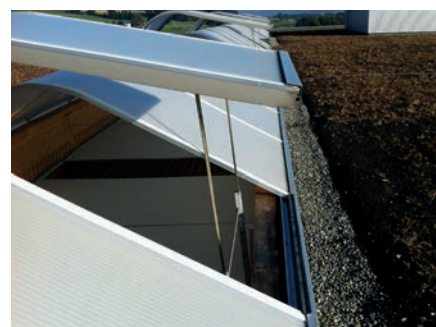
Voûte translucide avec vérin électrique à crémaillère en tandem
