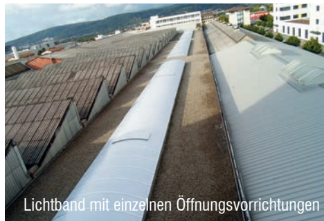
Gebogene Lichtbänder mit Öffnungsfunktionen, Flughafen Zürich
